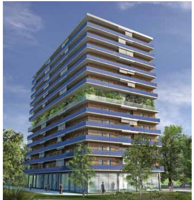
Façade Est / East elevation
