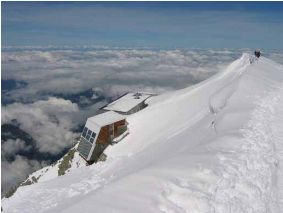
Etat actuel du Refuge du Goûter 3817m Au premier plan : le bâtiment conservé. En arrière plan : le bâtiment qui sera démonté.
